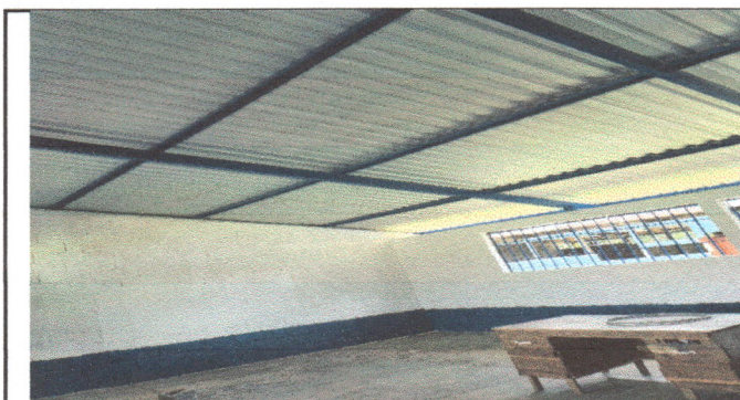
Foto 3: Cambio de costaneras.
