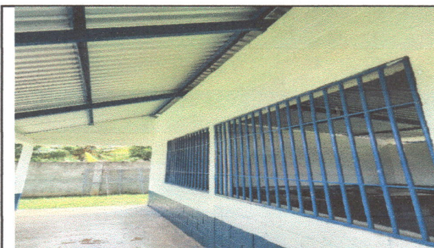
Foto 4: Mantenimiento de balcon.
