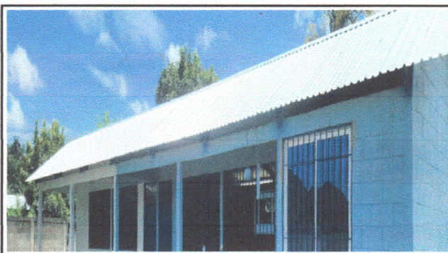
Foto 6: Instalacion de Lamina.
