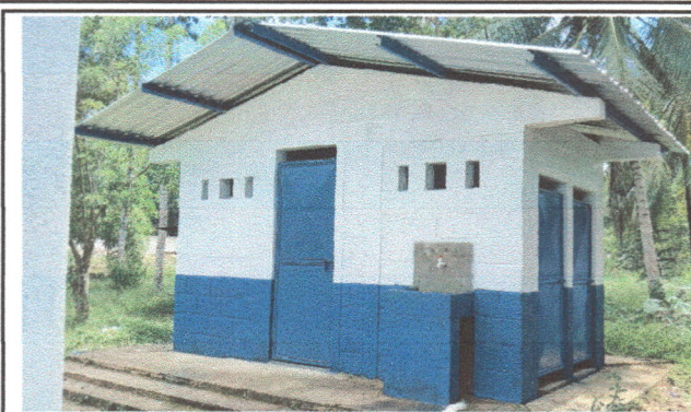
Foto 2: Mantenimiento de puertas de los baños.
