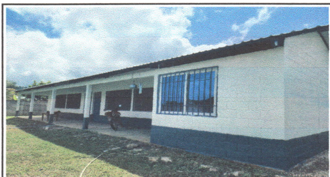
Foto 5: Instalacion de ventas PVC.
